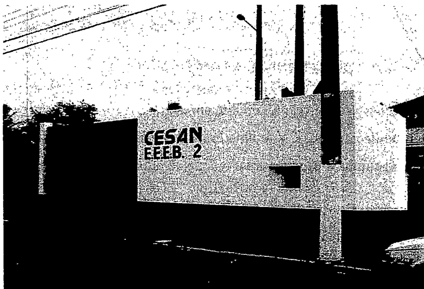
Figura 43 – Estação Elevatória de Esgoto bruto de Parati
