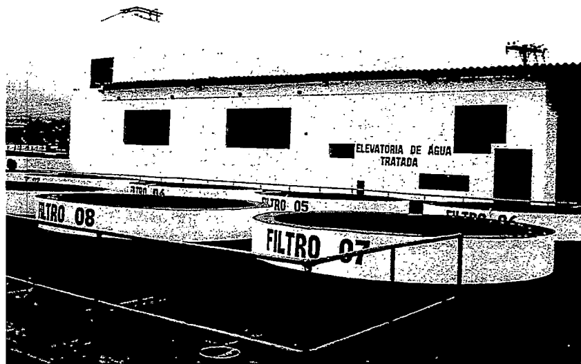
Figura 19 – Estação Elevatória de Água Tratada
