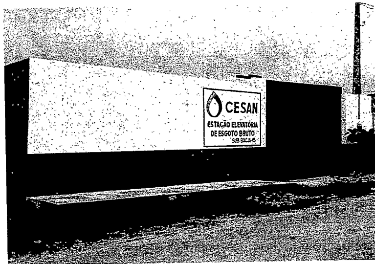
Figura 30 – Estação Elevatória de Esgoto Bruto – B15
