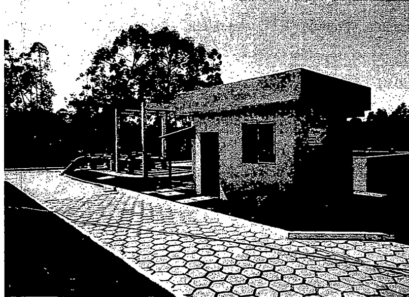
Figura 35 – Estação de Tratamento de Esgoto – ETE
