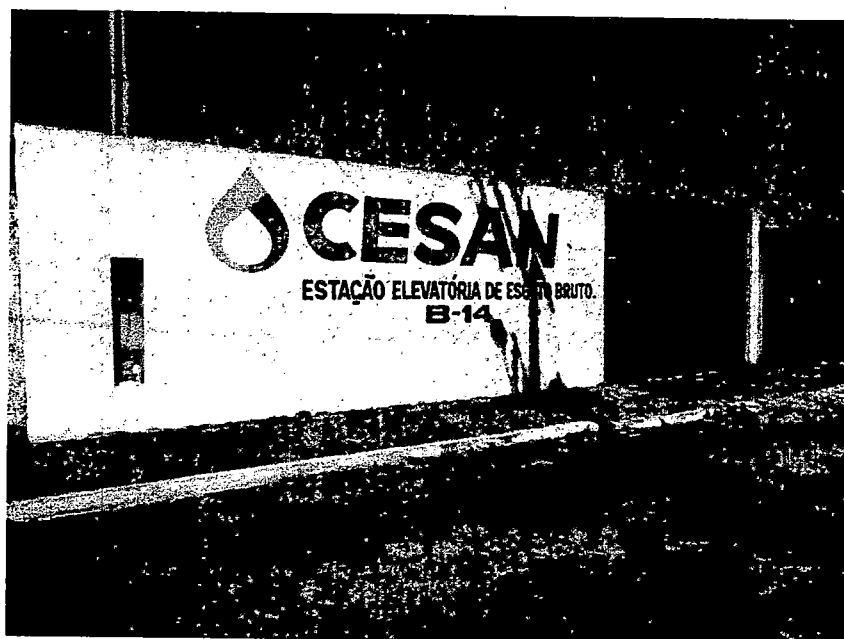
Figura 29 – Estação Elevatória de Esgoto Bruto – B14
