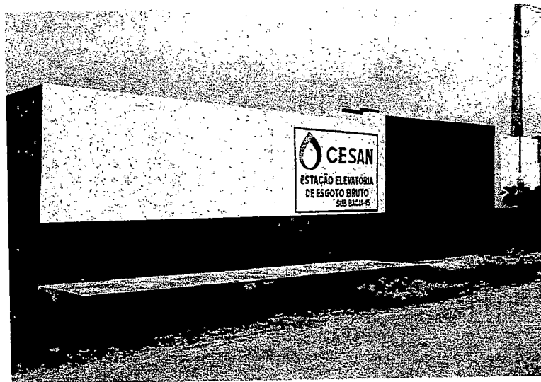
Figura 30 – Estação Elevatória de Esgoto Bruto – B15
