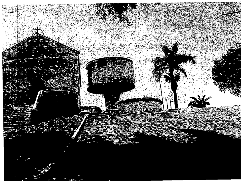
Figura 25 - Reservatório de Anchieta
