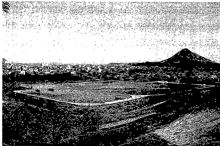
Figura 41 – Estação de Tratamento de Esgoto – ETE
