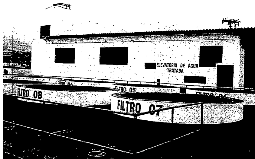
Figura 19 – Estação Elevatória de Água Tratada
